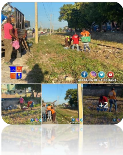
TRABAJOS DE LIMPIEZA REALIZADOS POR NUESTRAS BRIGADAS EN LOS RIELES DE SAN CARLOS.
