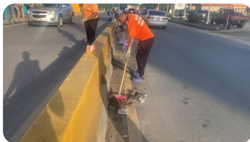
LIMPIEZA EN EL MURO JERSEY
