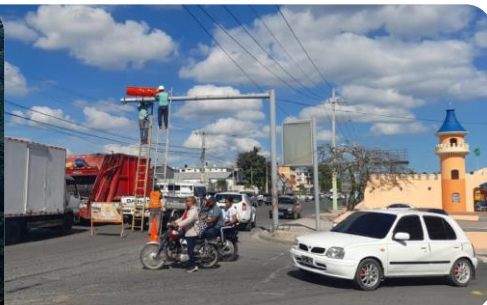
REPARACIÓN DE SEMÁFOROS
