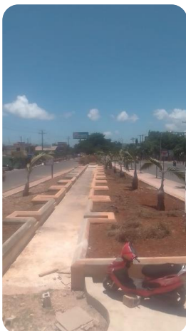
TRABAJOS EN LETRERO DE ENTRADA LA ROMANA
