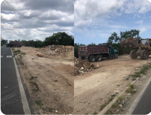
RECOGIDA DE ESCOMBROS EN LA AVE. CAAMAÑO DEÑO
