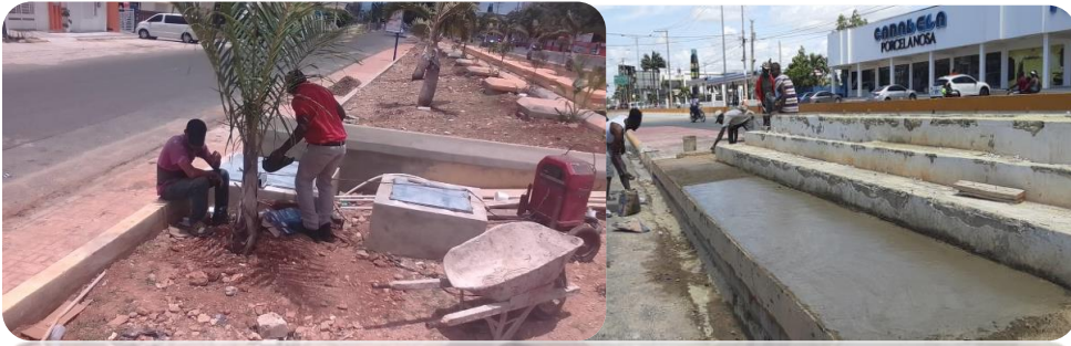
TRABAJOS EN LA ENTRADA-MONUMENTO
