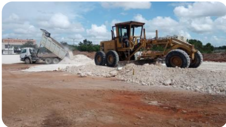
CONTINUACIÓN TRABAJOS APERTURA QUISQUELLA ROMANA DEL OESTE
