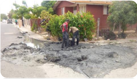
LIMPIEZA DE COLECTOR EN LA MANZANA 23
