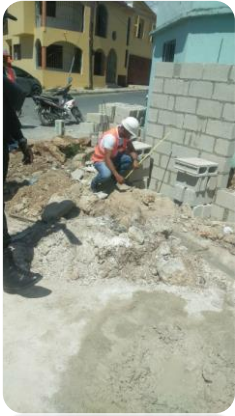
OPERATIVO DE RECUPERACIÓN DE ACERAS EN DIFERENTES SECTORES.
