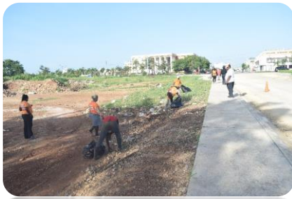
OPERATIVO DE LIMPIEZA EN LA APERTURA DE LA CALLE ROMANA DEL OESTE CON QUISQUELLA.
