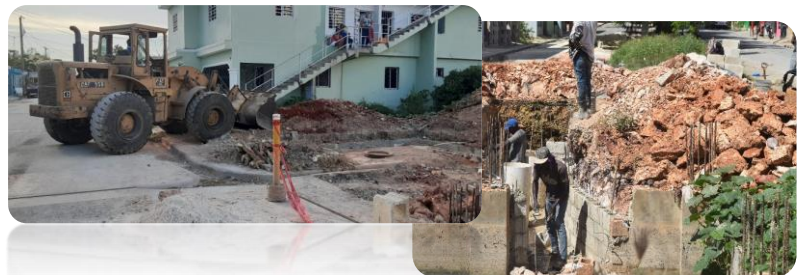
CONTINUACIÓN DE TRABAJOS EN COLECTOR PLUVIAL DE VILLA SAN CARLOS.
