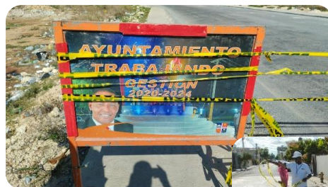
CONSTRUCCIÓN DE BADEN Y REPARACIÓN DE PARRILLAS EN LA APERTURA QUISQUELLA ROMANA DEL OESTE.
