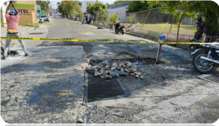
REPARACIÓN DE LOZA CALLE HÉCTOR P. QUEZADA ESQUINA DR. HERNÁNDEZ.
