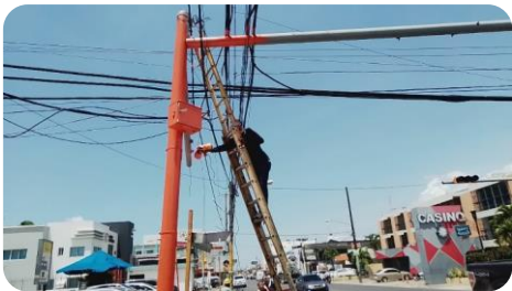
REPARACIÓN DE SEMÁFORO EN LA AV. PADRE ABREU.
