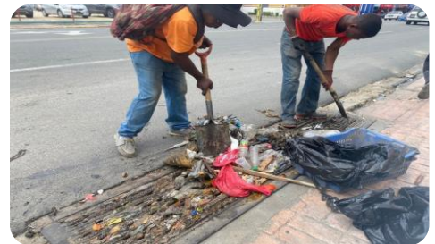
OPERATIVO DE LIMPIEZA PROFUNDA EN LOS IMBORNALES DE LA AV. PADRE ABREU.
