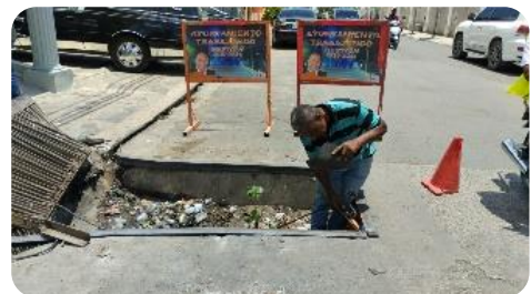
REPARACIÓN DE ALCANTARILLA FRENTE A LA FUNERARIA ROMANA.
