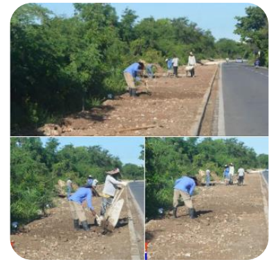
CONTINUAMOS CON LA CONSTRUCCIÓN DE ACERAS EN LA AVENIDA CAAMAÑO DEÑO.
