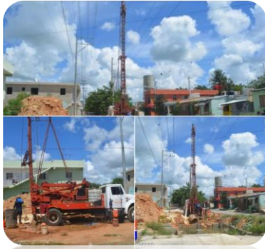
CONTINUACIÓN DE LOS TRABAJOS DEL COLECTOR PLUVIAL DE VILLA SAN CARLOS.
