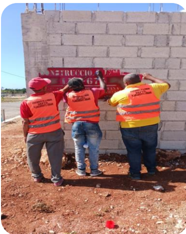
OPERATIVO DE SUSPENSIÓN DE OBRAS.
